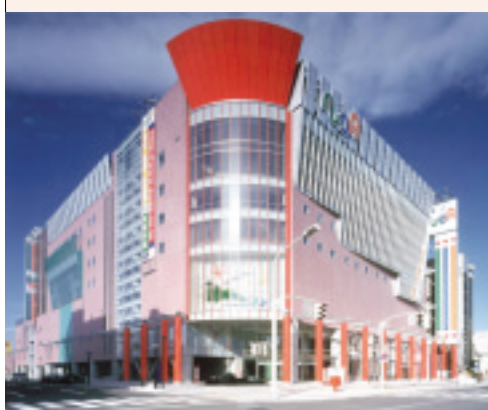
コンパクトシティづくりの先進事例である青森市の複合型商業ビル「アウガ」（地下1～地上9階）。青森駅前再開発によってオープンし、生鮮市場や商業施設、そして図書館等の公共施設も入居している。
